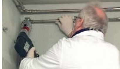
Fig. 16 - Sammenpresning av rør og rørdel
