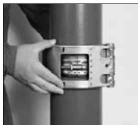
3. Påse at koblingens bolt er tilgjengelig, og fest boltene på kragen.
